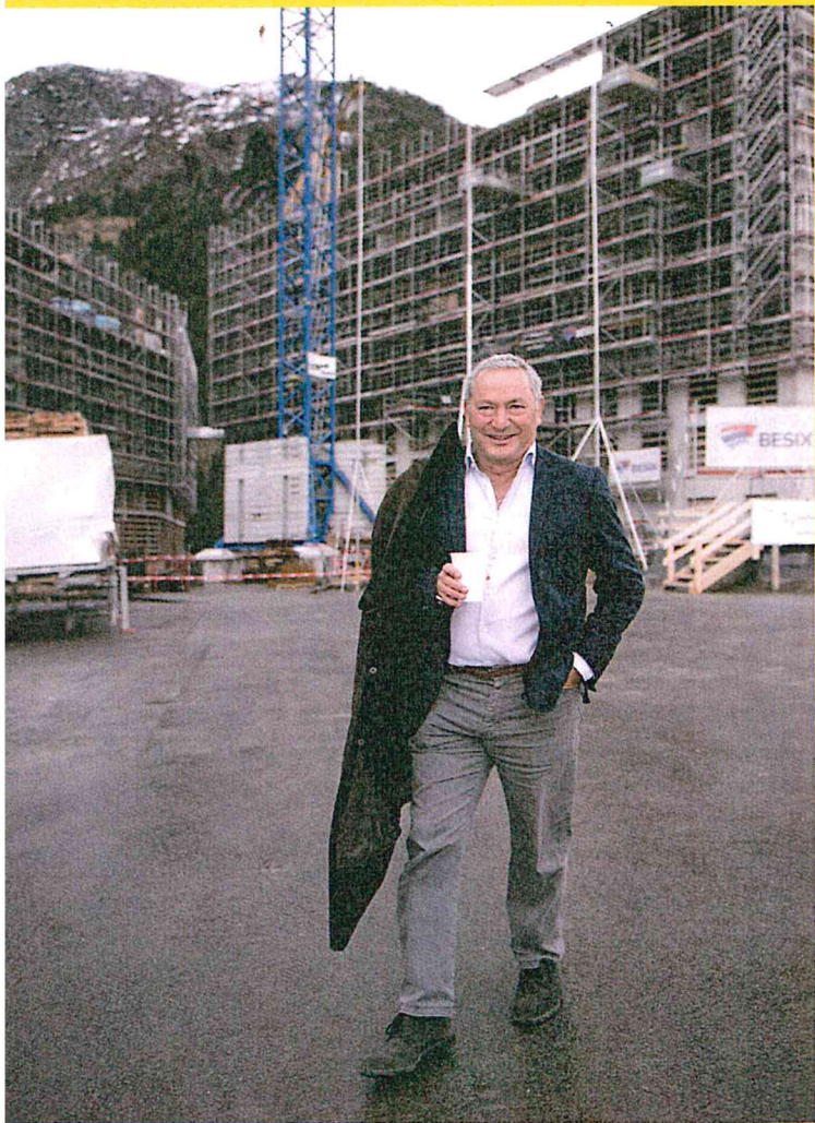
Milliardär und Bauingenieur Samih Sawiris auf seiner Baustelle in Andermatt. Rechts der Lageplan mit dem neuen Ortsteil. Fotos: Valentin Luthiger (links) und Andermatt Swiss Alps (rechts)
